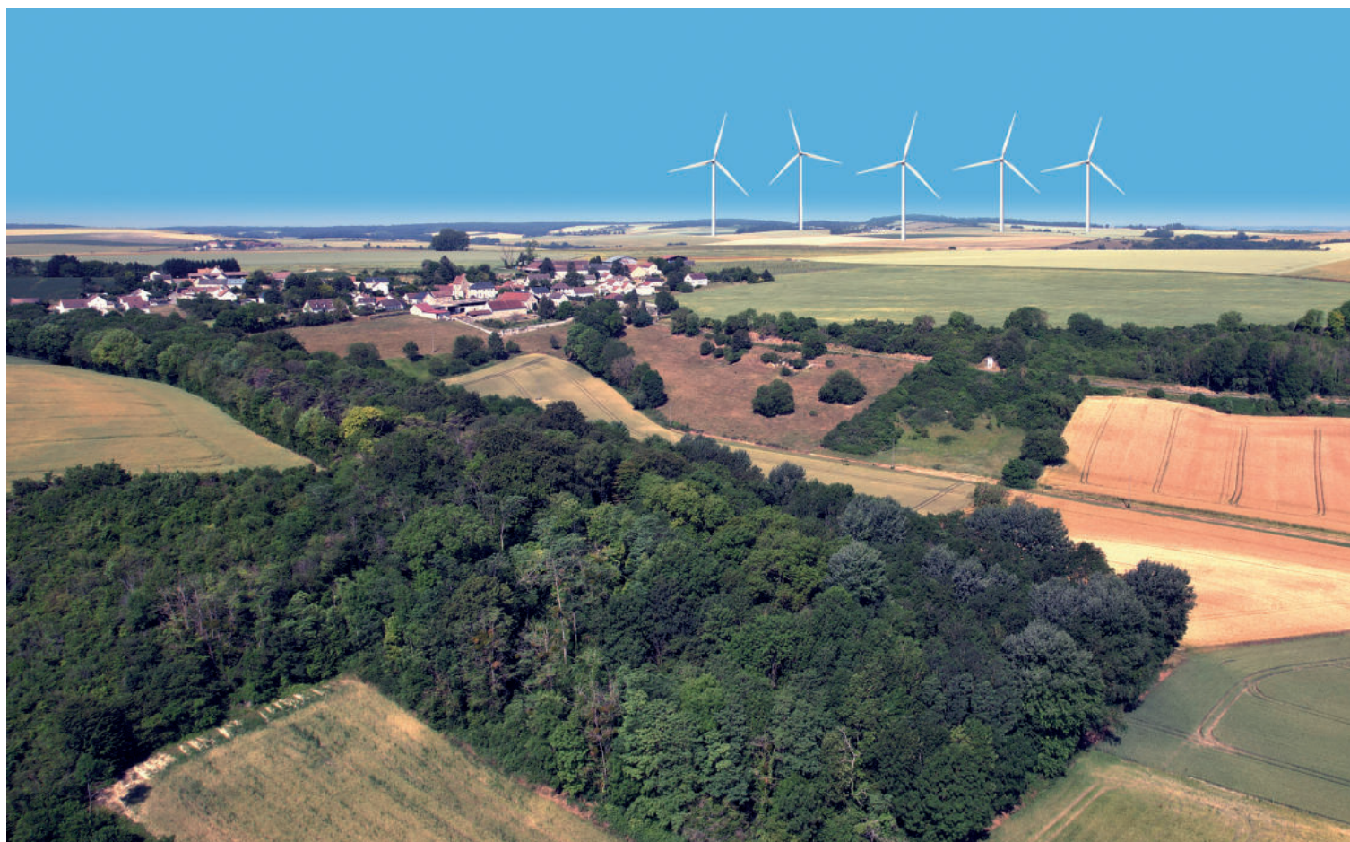
▲ Projet Mont-Saint-Martin - Vue de Mont-sur-Courville
