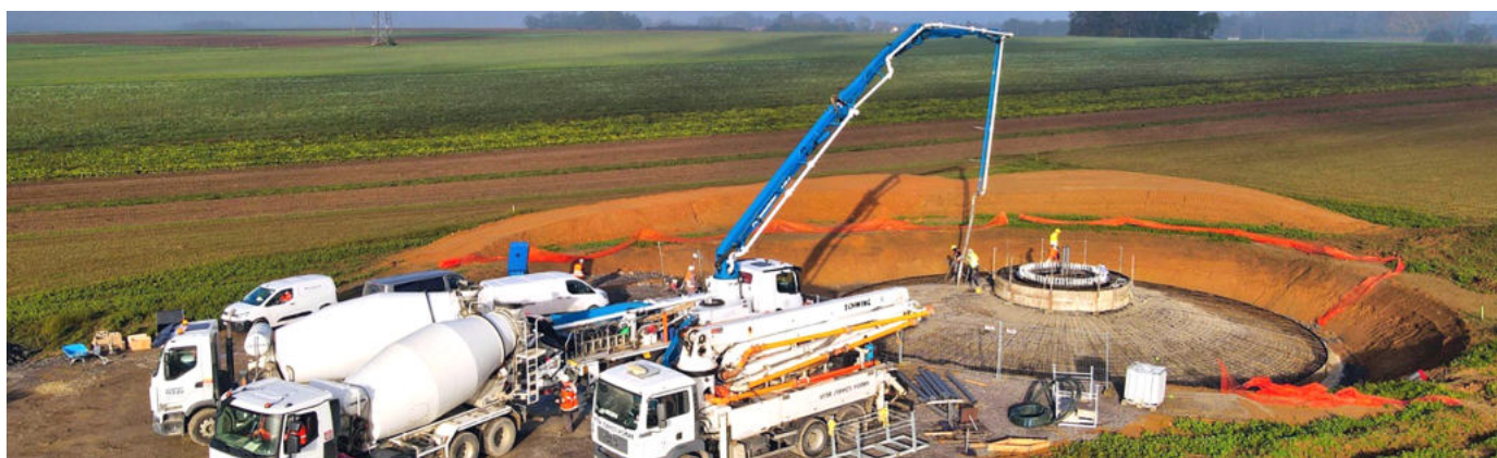
▲ Socle de béton
